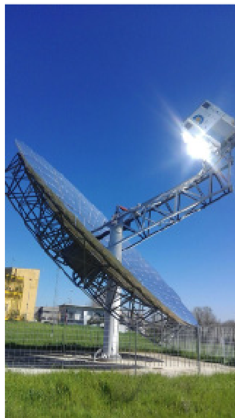
Impianto OMSoP in inseguimento solare
