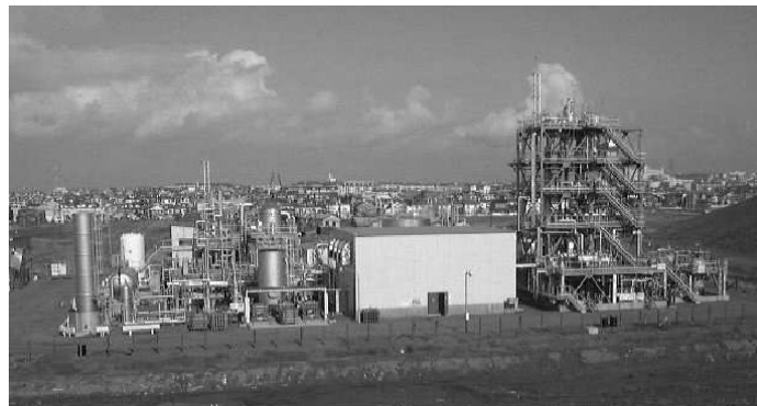
Figura 4.4. Impianto pilota della NKK da 5 tonnellate giornaliere di DME.
