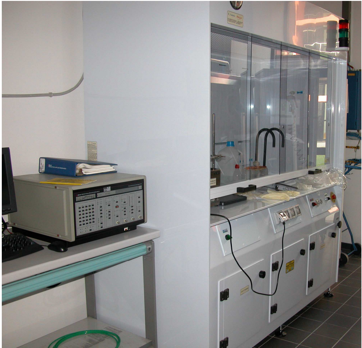
Foto della cappa installata nel Laboratorio Celle Fotovoltaiche Polimeriche .
