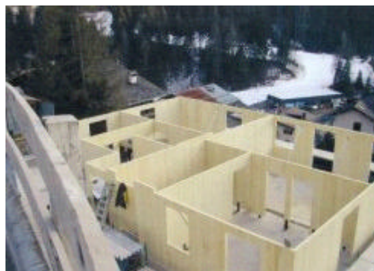
Figura 2: Sistema di costruzione a pannelli multistrato
