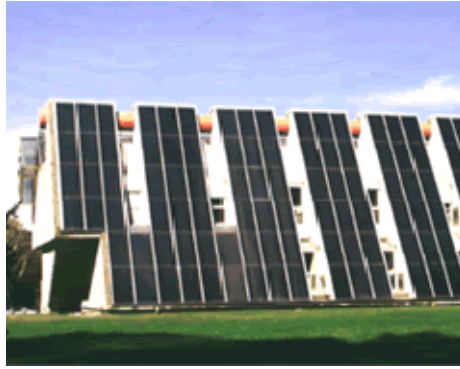
Figura 3. Collettori solari ad aria integrati nella parete sud del corpo A.
