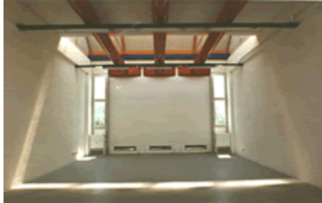
Figura 5. Laboratorio al secondo piano del corpo B. In fondo si può notare la parete interna del componente parete camino solare con le tubazioni di distribuzione delle bocchette di ripresa dell'aria.
