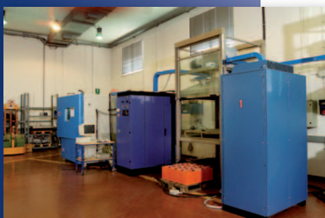
Stazione di prova batterie
