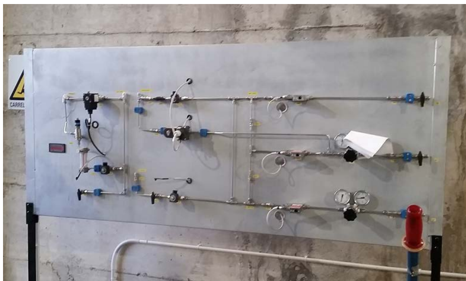
Sistema di iniezione gas dell'impianto BID1 (linea per argon, idrogeno e aria)
