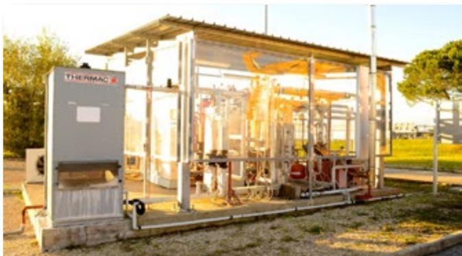
**Climatizzazione sostenibile: impianto di solar heating and cooling.** L'impianto utilizza energia solare ed è stato realizzato allo scopo di riscaldare durante l'inverno e rinfrescare durante l'estate. Le opportunità nei Paesi di cooperazione potrebbero essere molte, a cominciare dall'uso dell'impianto, che ha costi molto bassi, per la conservazione di cibi
