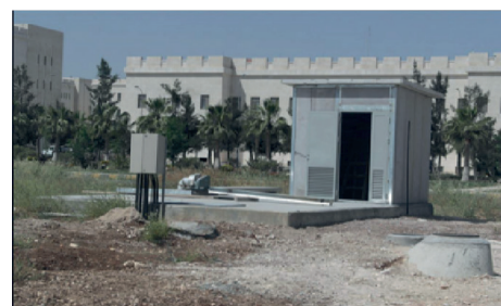
Stazione di arrivo dei reflui all'impianto di trattamento decentralizzato operante con tecnologia SBR a servizio del Dipartimento di Polizia della municipalità di Amman
