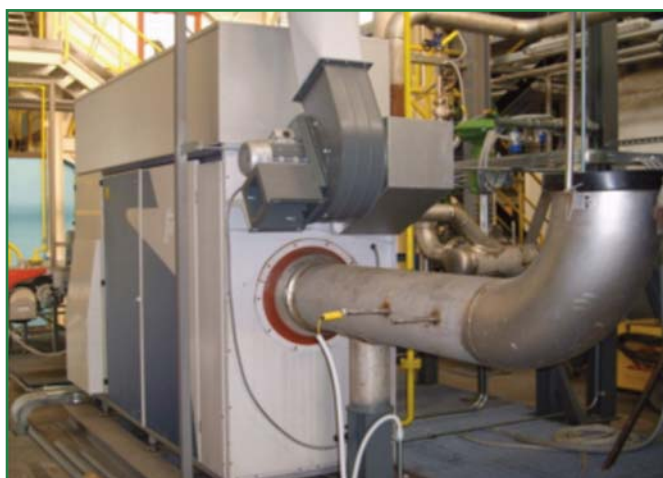
Impianto ZECOMIX: microturbina
