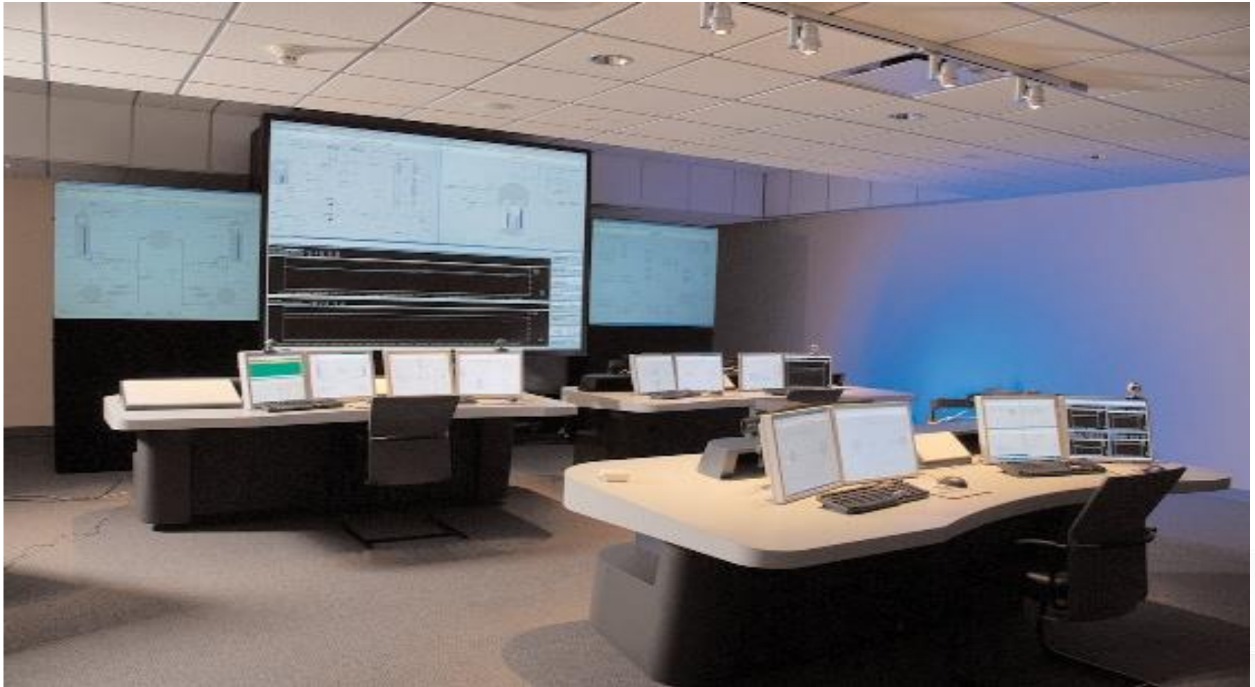
Simulatore di addestramento : replica di Sala Controllo (per la gestione del sistema)
