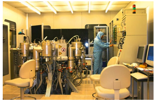
Immagine nella prima pagina dell'articolo: Centro Ricerche ENEA di Portici (Napoli) – Camera "pulita" per la deposizione e l'irraggiamento laser di materiali per i moduli fotovoltaici
