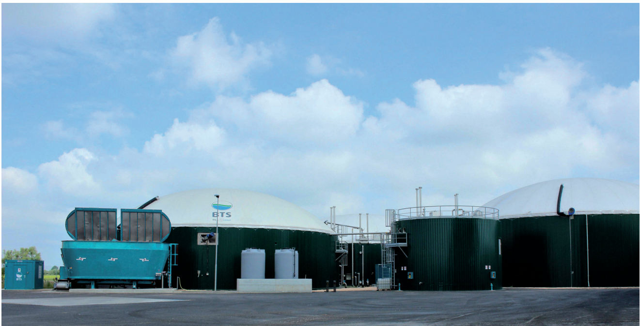
Impianto per la produzione di biogas realizzato dalla BTS Biogas
