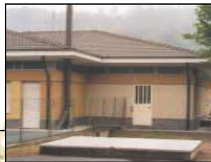
Centrale termica di Zimone
